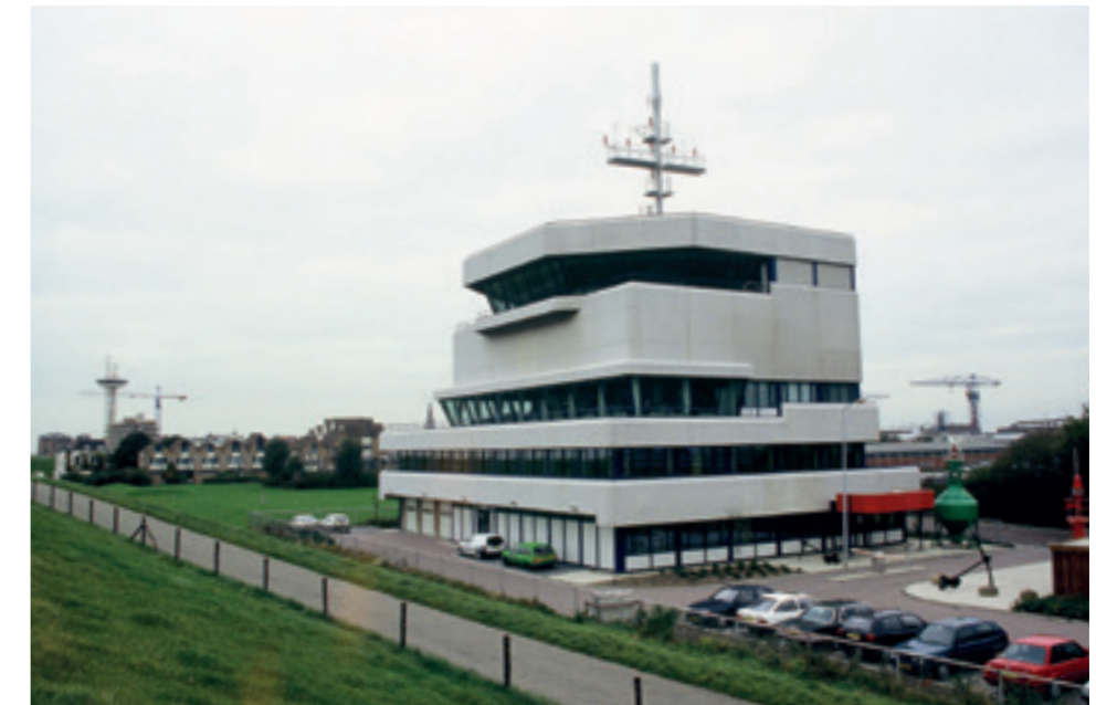
De verkeerscentrale Vliissingen
